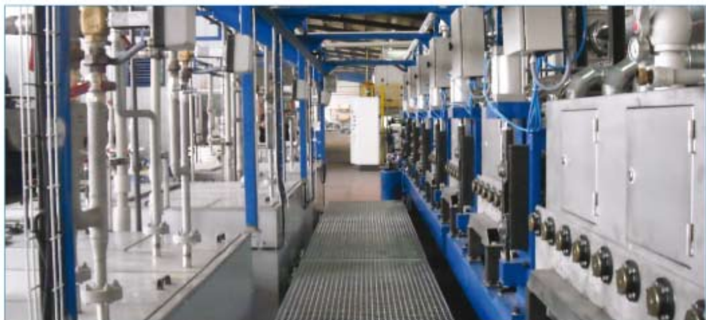
Las nuevas instalaciones en Miranda de Ebro han sido construidas con tecnología propia de los ingenieros de Alucoil y Albérico.
